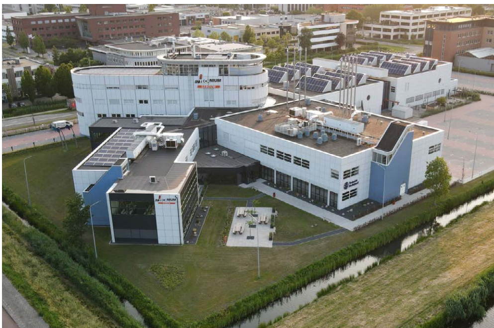
Figuur 3 Zijaanzicht op bouwdeel A (links) en B (rechts), met eigen entree en toegang via het parkeerterrein. Bouwdeel C is te zien aan de achterzijde (bron: foto VDH).
